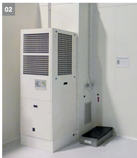
02 . Unità di trattamento aria MAE
