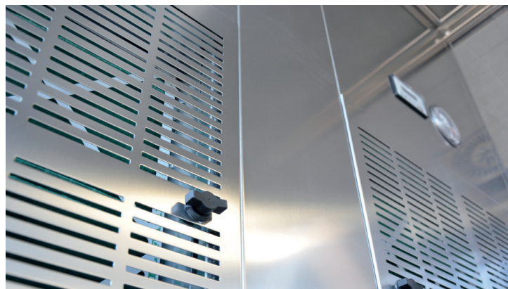
02 . Dettaglio griglie di ripresa 02 . Detail Intake grid
