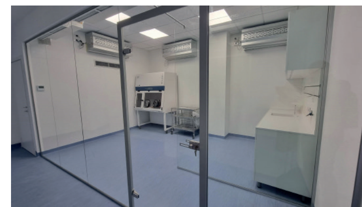
04. Esempio di locale classificato ISO8 secondo ISO14644 grazie all'utilizzo di un gruppo di unità LEAVES
