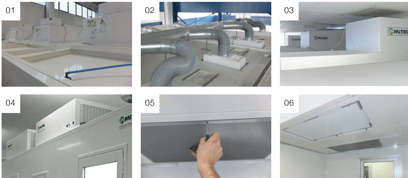
01 . MTF 4824 AUT S installati su HARDWALLS CLEANROOM senza climatizzazione 02 . MTF 4824 AUT S installati su HARDWALLS CLEANROOM e collegati mediante plenum realizzato con canali 03 . MTF 4824 AUT LB installati su HARDWALLS CLEANROOM senza climatizzazione 04 . MTF 4824 AUT LB lato presa aria 05 . Smontaggio diffusore MTF 4824 AUT S per sostituzione filtro HEPA 06 . Dettaglio MTF 4824 AUT S privo di diffusore con filtro HEPA in primo piano
